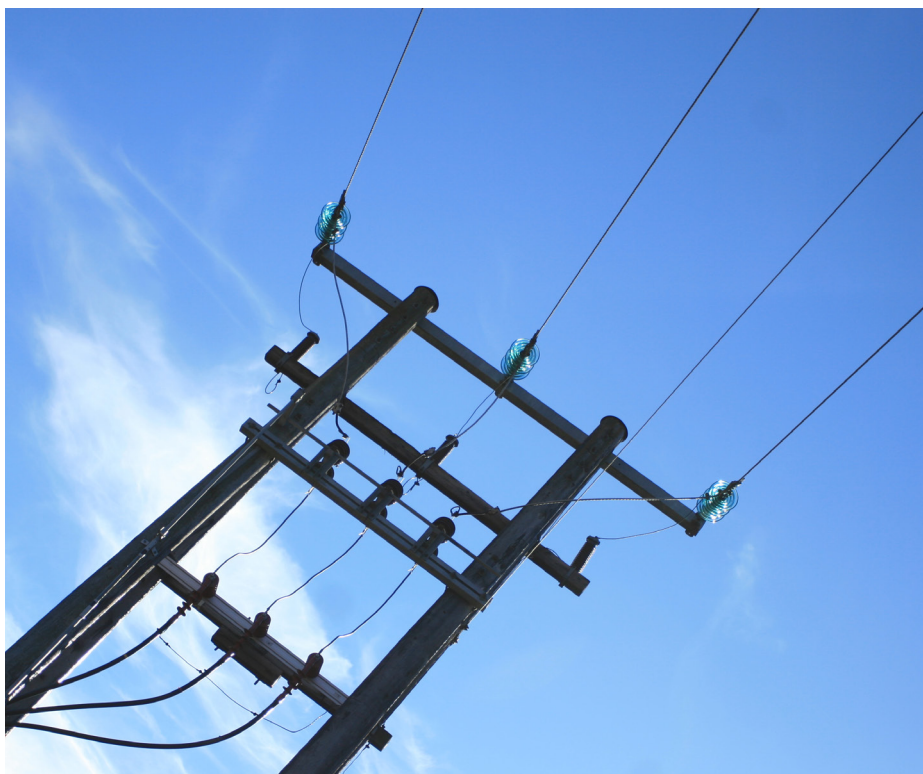
Leverandører av nettjenester og elektrisk energi kan utstede felles fakturaer.
